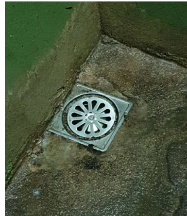
รูปที่ 2-22 ท่อรวบรวมน้ำจากห้องพักขยะมูลฝอย
