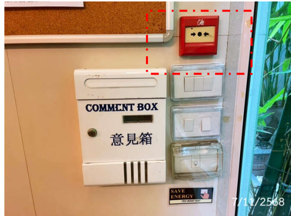
อุปกรณ์แจ้งเหตุเพลิงไหม้ด้วยมือ (Manual Call Point)
