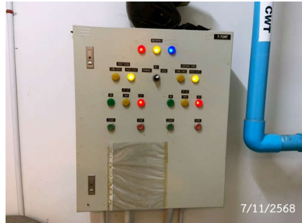
ตู้ควบคุมระบบสูบน้ำ
